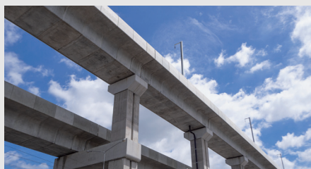
橋梁の変位計測
