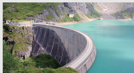
ダム堤体変位計測
