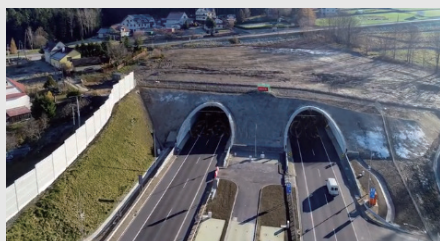
地表面沈下計測
