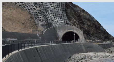
供用中のトンネル上部の地滑り管理
