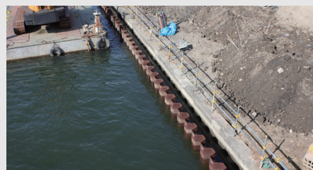
矢板・擁壁の倒れ管理
