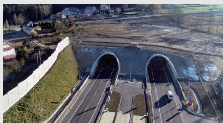
地表面沈下計測
