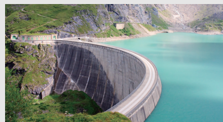
ダム堤体変位計測
