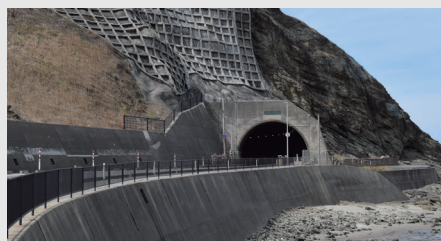
供用中のトンネル上部の滑り管理
