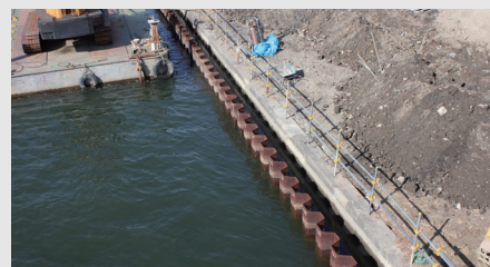
矢板・擁壁の倒れ管理
