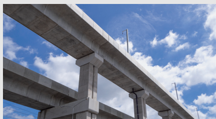
橋梁変位計測
