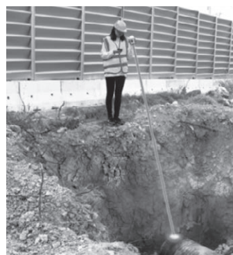
図-8 立坑底面の観測
