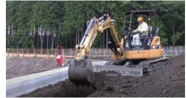
道路改良舗装工事 (静岡県)
