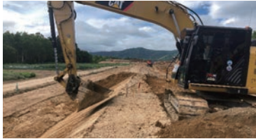
農地法面整正工事 (北海道)
