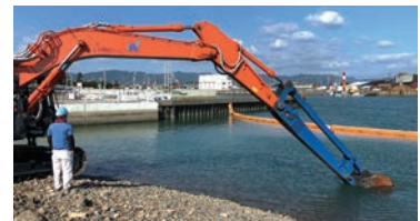
護岸整備工事 (和歌山県)
