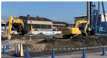
地盤改良工事 (広島県)
