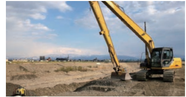
災害復旧工事 (富山県)
