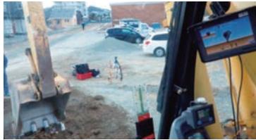
床付け工事 (神奈川県)
