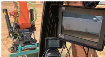
太陽光発電所建設工事 (京都府)
