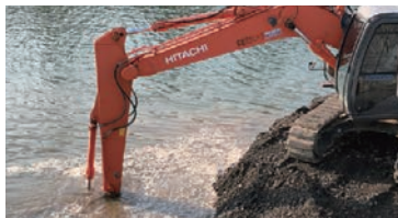
河川整備工事 (和歌山県)
