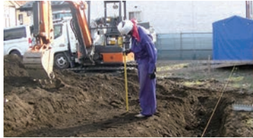
住宅基礎工事 (山梨県)
