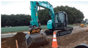
道路掘削工事 (愛知県)
