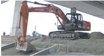
築堤護岸工事 (東京都)
