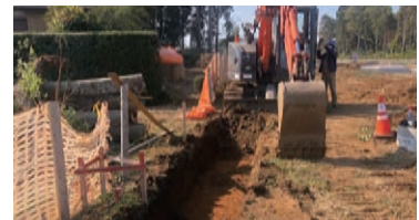
水路布設工事 (千葉県)
