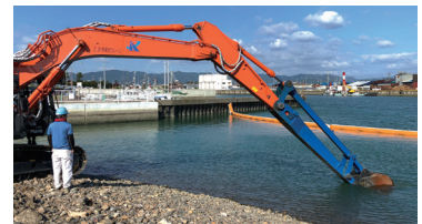
護岸整備工事 (和歌山県)
