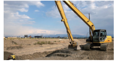
災害復旧工事 (富山県)
