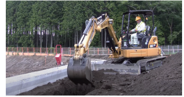
道路改良舗装工事 (静岡県)
