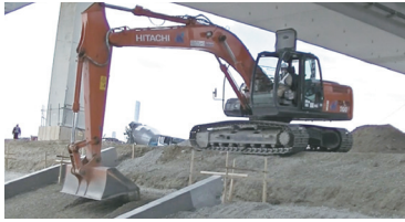
築堤護岸工事 (東京都)
