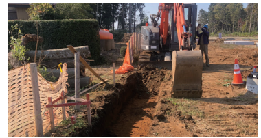
水路布設工事 (千葉県)
