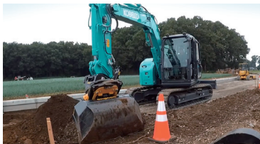
道路掘削工事 (茨城県)
