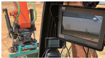
太陽光発電所建設工事 (京都府)
