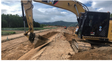
農地法面整正工事 (北海道)
