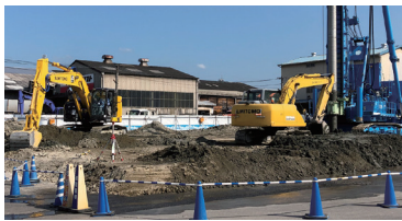
地盤改良工事 (広島県)
