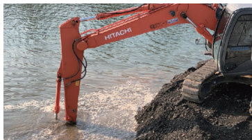
河川整備工事 (和歌山県)
