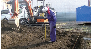
住宅基礎工事 (山梨県)
