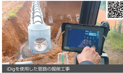
iDigを使用した管路の掘削工事
