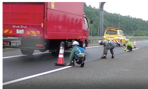
写真-1 切削端部のマーキング状況
