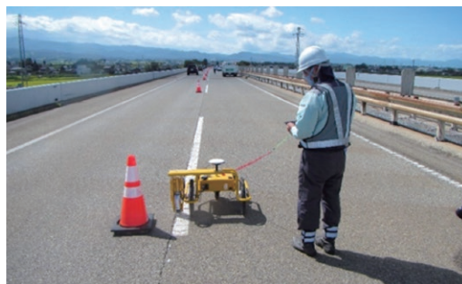
写真-7 供用車線側でのマーキング作業
