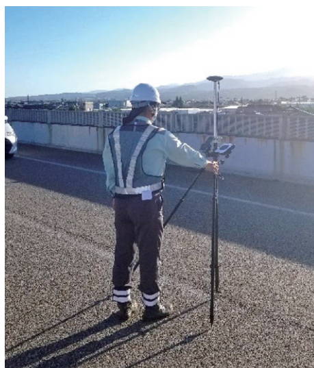
写真-4 GNSSローバーによる測量
