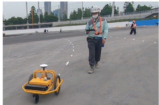
写真-6 曲線部のマーキング状況
