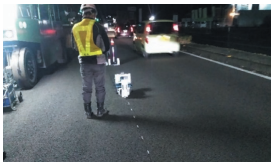
写真-7 現場供用試験状況
