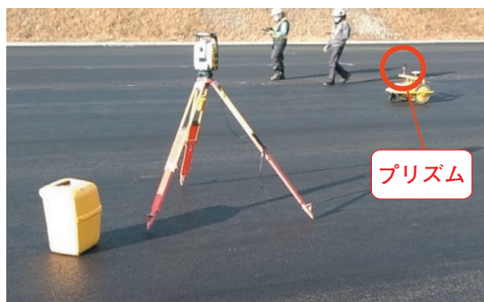
写真-8 自動走行ロボットでの検測状況
