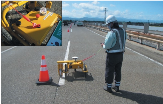
写真-4 規制際での自動走行ロボット作業と非常停止スイッチ (左上)
