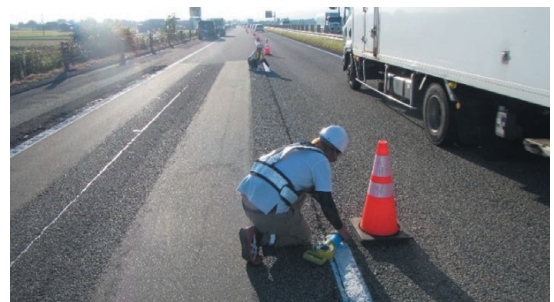
写真-1 高速道路での通り出し作業状況
