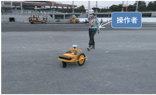
写真-3 現場試用状況
