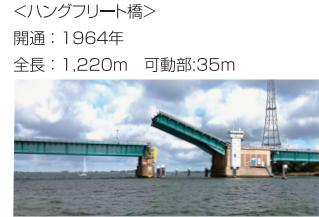
オランダ ハーリングフリート橋は、全長約1200mで一部に35mの可動部(跳ね橋)があります。ハーリングフリート川をわたる高速道路A29号線と一般車線が通っています。船は橋の固定部の下13mまで通過することができ、背の高い船やプレジャーボートの為に橋の可動部が開かれます。
