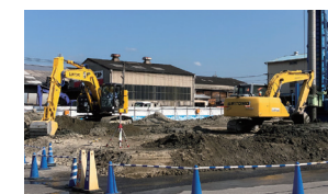
地盤改良工事 (広島県)
