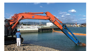
護岸整備工事 (和歌山県)
