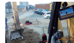
床付け工事 (神奈川県)
