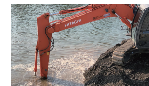
河川整備工事 (和歌山県)
