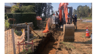
水路布設工事 (千葉県)
