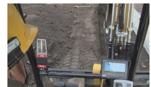
道路改良舗装工事 (静岡県)
