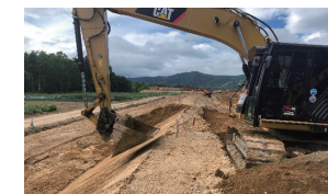
農地法面整正工事 (北海道)
