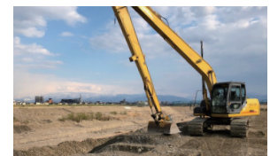
災害復旧工事 (富山県)
