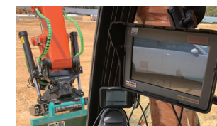
太陽光発電所建設工事 (京都府)
