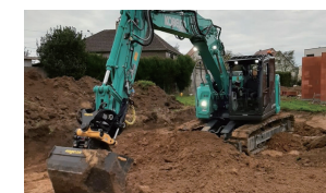
掘削工事 (茨城県)
