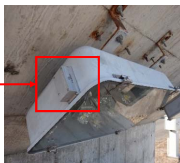
照明灯具への取付状況
