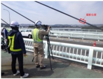
計測状況 (撮影状況)
