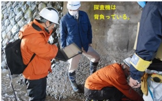
橋台下洗掘探査状況写真
