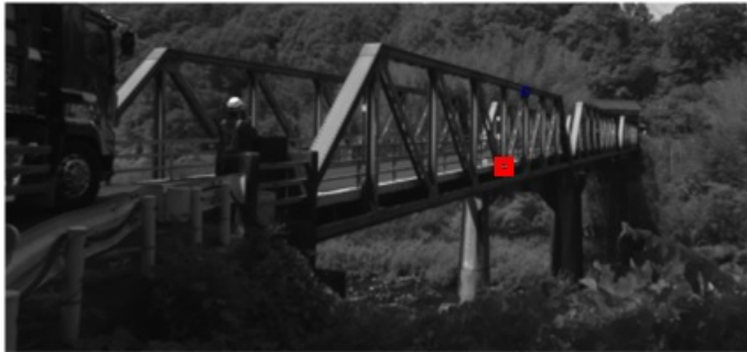
図3 本技術で撮影した画像、解析したい場所を選択(赤四角部分)
