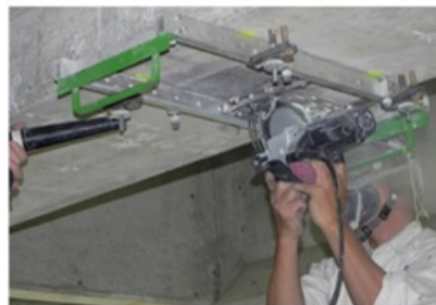
図-2 スリット切削用コンクリートカッター
