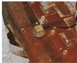
写真6.3 加速度センサの設置(1)
